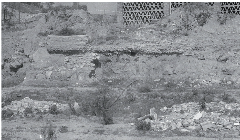
Figura 8. Fotografia de les construccions a diferent cota de l'Establiment de les Puntes. Vista des de la plataforma inferior on es veu el tall de la nova carretera. Arxiu J. M. Cuyàs.
