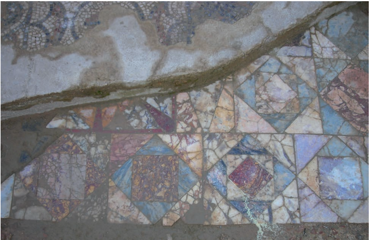
Paviment original en opus sectile de la sala d'aparat A15.
