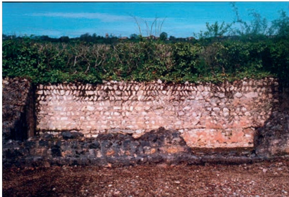
Figure 8. Villa de Montmaurin : traces des campagnes de ré-appareillages successives (R. Dupont).
