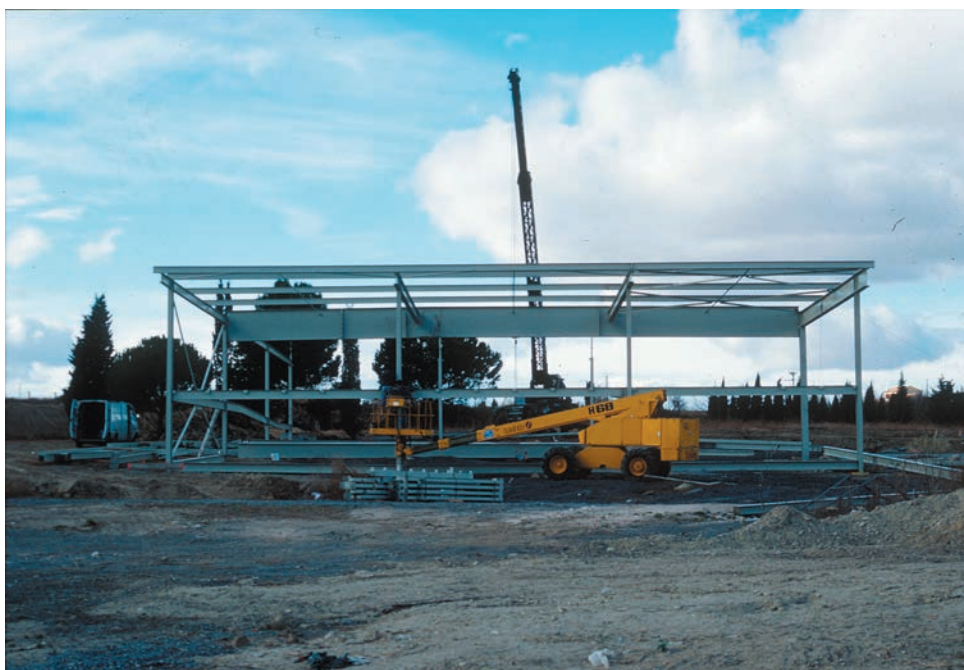
Figure 9. Une étape décisive, le site archéologique accueille le chantier de construction du bâtiment de protection. Remblaiements et utilisation de fondations sous la forme de micropieux permettront de respecter les impératifs de protection des vestiges. Cliché Villa-Loupian, CCNBT.
