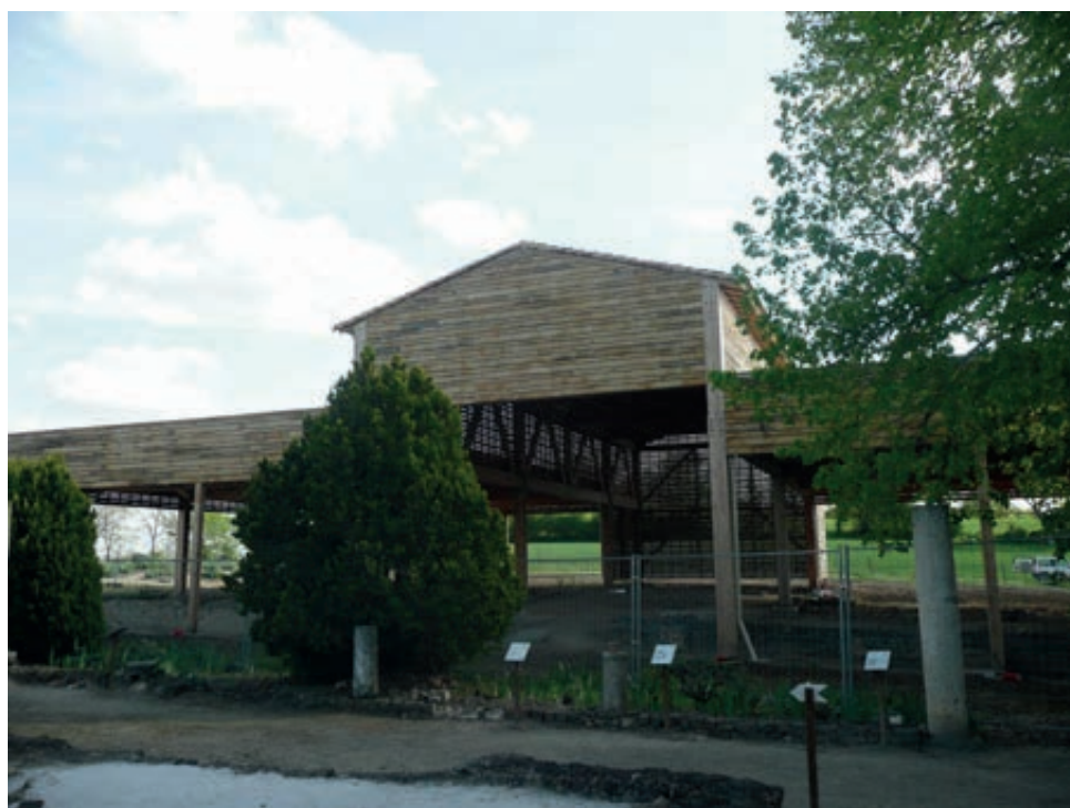
Figure 6. Bâtiment de protection des thermes (Br. Fages).
