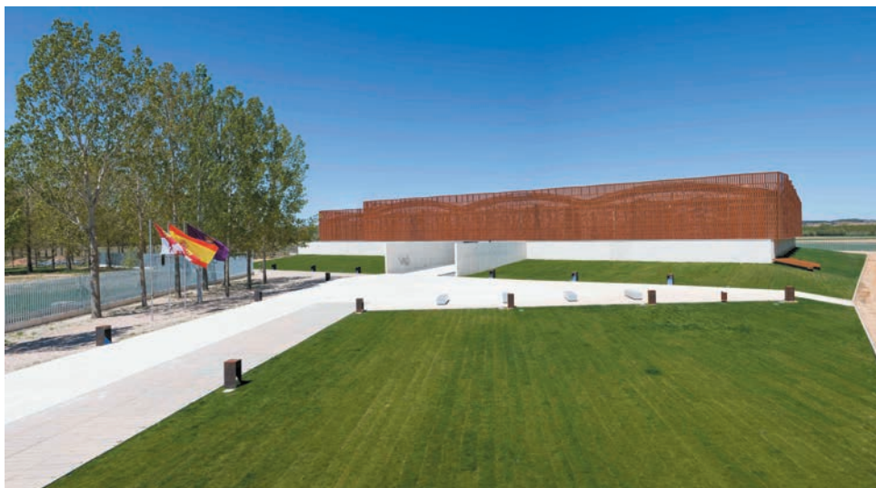
Figura 1. Aspecto actual del edificio que protege los restos de la villa romana La Olmeda.
