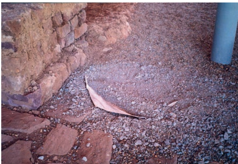
Figure 9. Site d' Imus Pyrenaeus (Saint-Jean-le-Vieux, France, Pyrénées-Atlantiques) : film protecteur dans les remblais (R. Dupont).
