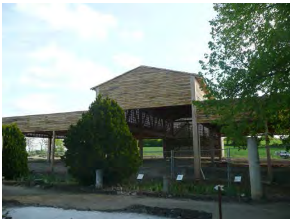
Figure 6. Bâtiment de protection des thermes (Br. Fages).
