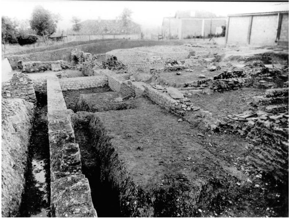
Figure 9. Restaurations/ restitutions en cours. (les différences de teinte différencient encore les murs antiques des autres).
