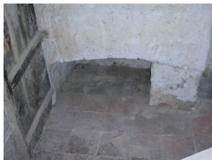
Fig. 74. Coronament del capialt de la porta medieval d'entrada al recinte.
