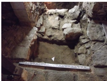
Fig. 40. Cala oberta a l'àmbit 21.
