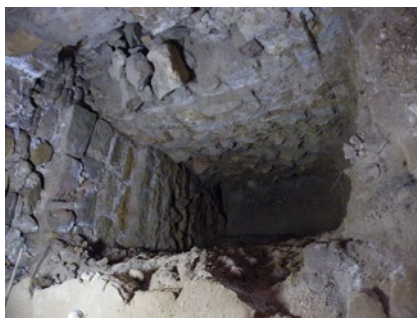
Fig. 64. Aspecte de la cala que uns afeccionats locals van obrir a l'angle interior format per la intersecció del mur perimetral sud i el mur de tanca oest del pati. S'observa la potent fonamentació.
