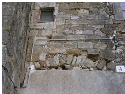
Fig. 73. Sobre la porta d'accés, del segle XVIII, es pot apreciar la petja semicircular de les dovelles de la porta medieval.
