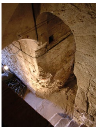
Fig. 75. Detall exterior de la porta inferior de la torre.
