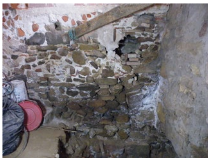
Fig. 80. Arrencament de l'arc de migdia de la paret oest del pati.
