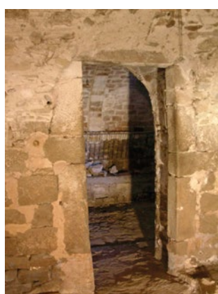
Fig. 78. Aspecte de la porta nord oberta a la paret oest de l'antic pati.
