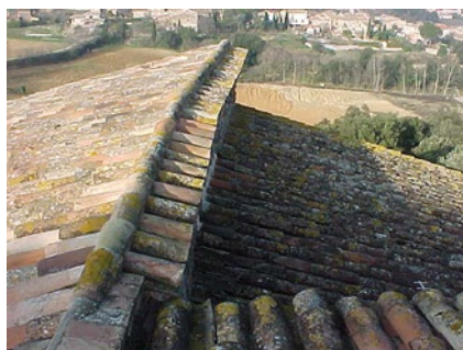
Fig. 102. Vista de la coberta a doble vessant del recinte annex.
