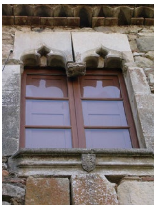
Fig. 87. Finestra de doble arc conopial a la façana nord. L'escut de l'ampit reproduueix les armes dels vern i dels Foixà-Boixadors.
