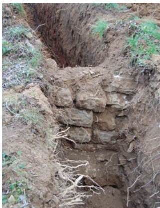
Fig. 6. Mur UE 2 a la rasa núm. 8.
