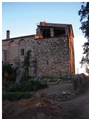
Fig. 107. Vista de la part oriental de la façana sud de l'edifici on s'observa l'escassa qualitat de la paret moderna amb què referen la torre.
