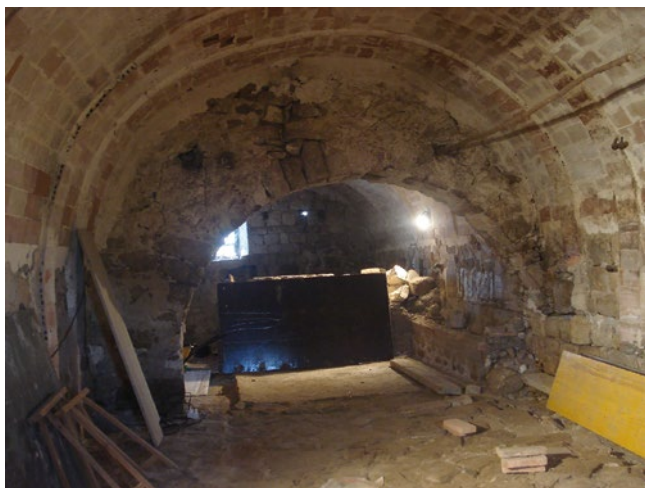
Fig. 81. Arc de cruïlla de la planta inferior del cos d'edifici de ponent de Torre Desvern.
