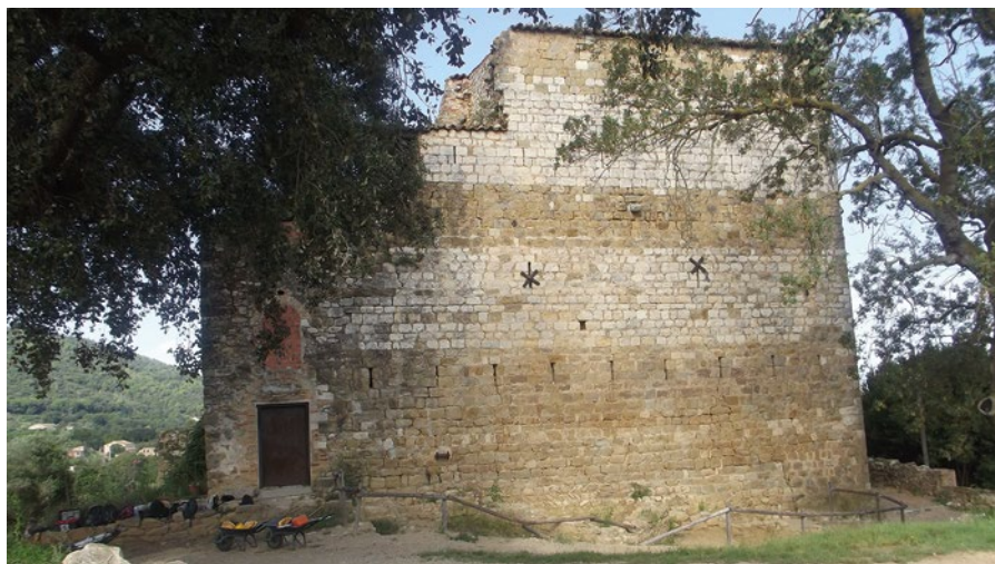
Fig. 65. Façana est de la torre. S'observa un petit tram del mur obrat en espina de peix sobre la banqueta de fonamentació.
