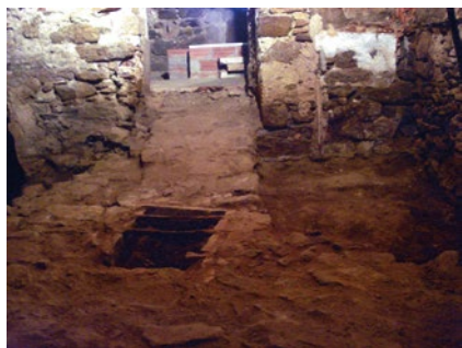
Fig. 51. Vista inicial de l'àmbit 23 abans de començar la campanya del 2017.
