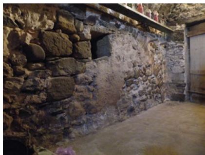
Fig. 79. Vista de l'arcada al sud-oest del pati, que avui es conserva paredat.
