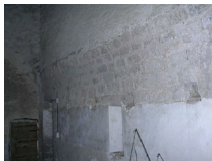
Fig. 72. Arrencament de la volta de canó seguit de la sala.
