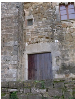
Fig. 97. Vista general de l'accés septentrional al recinte.
