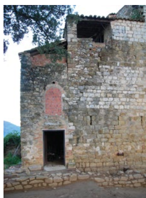
Fig. 105. Vista del tram meridional de la façana est de la torre. S'observa la diferència entre el parament medieval i la refecció moderna.
