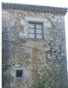
Fig. 103. Vista de la coberta a doble vessant del recinte annex.
