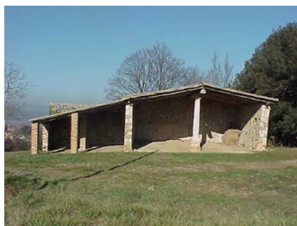
Fig. 111. Vista general de l'era, situada pocs metres al nord-est de l'edifici.
