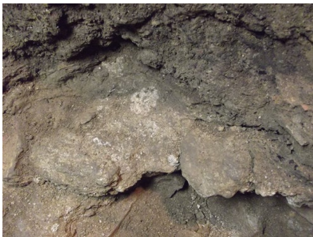
Fig. 38. Vista d'un fragment del paviment de morter (UE 4017).
