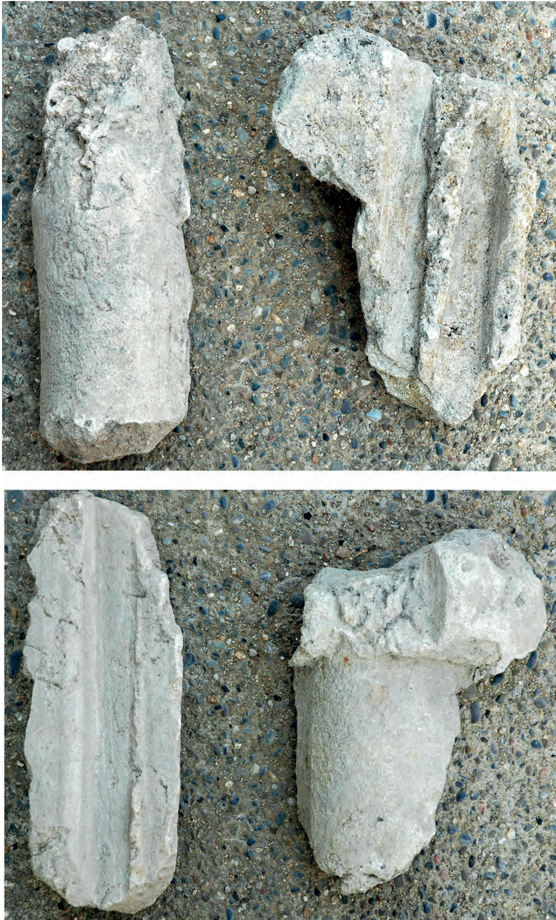
Figura 83. Empremses de teules deixades damunt dels blocs de morter
