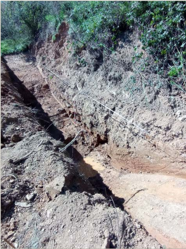
Figura 1. Vista de la reobertura del retall efectuat l'any 2020, amb el nou perfil del canal antròpic excavat en el dipòsit miocènic.
