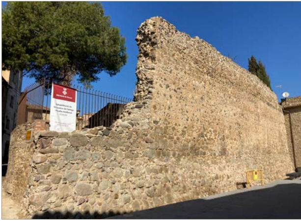
Figura 1. Vista general de la façana est del mur, després de la intervenció.
