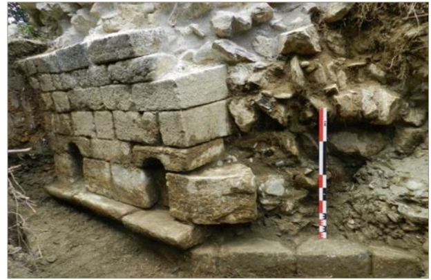
Figura 1. Vista del parament de l'estrep i el fonament del trenca-aigües.
