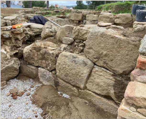
Figura 2. Vista del mur 1828, durant la intervenció de reconstrucció.
