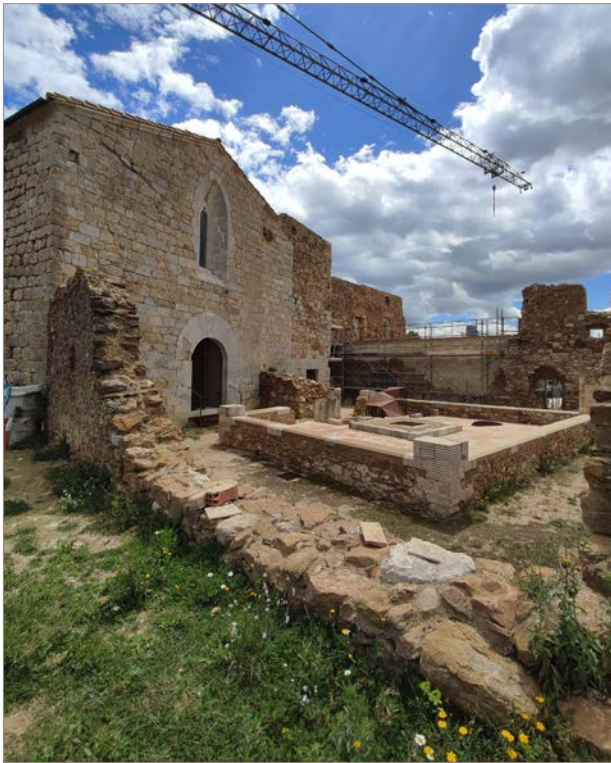
Figura 2. Vista general de les restes del claustre de la canònica de Santa Maria del Roure, descobert durant les obres de restauració.
