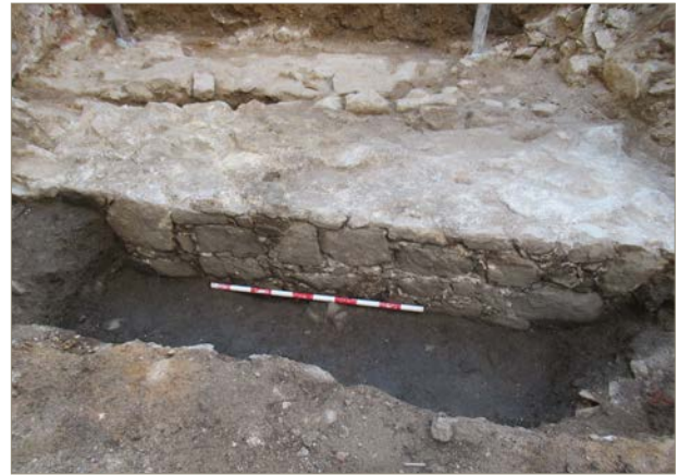
Figura 1. Detall del reforç modern i la cara interna de la muralla baixmedieval.
