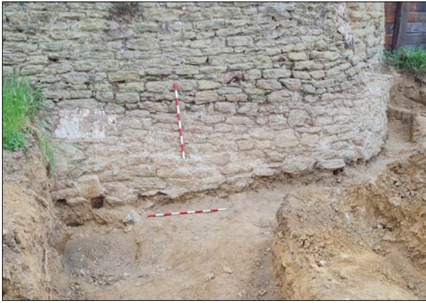
Figura 1. Zona oest de la muralla, construïda directament sobre el subsol natural.
