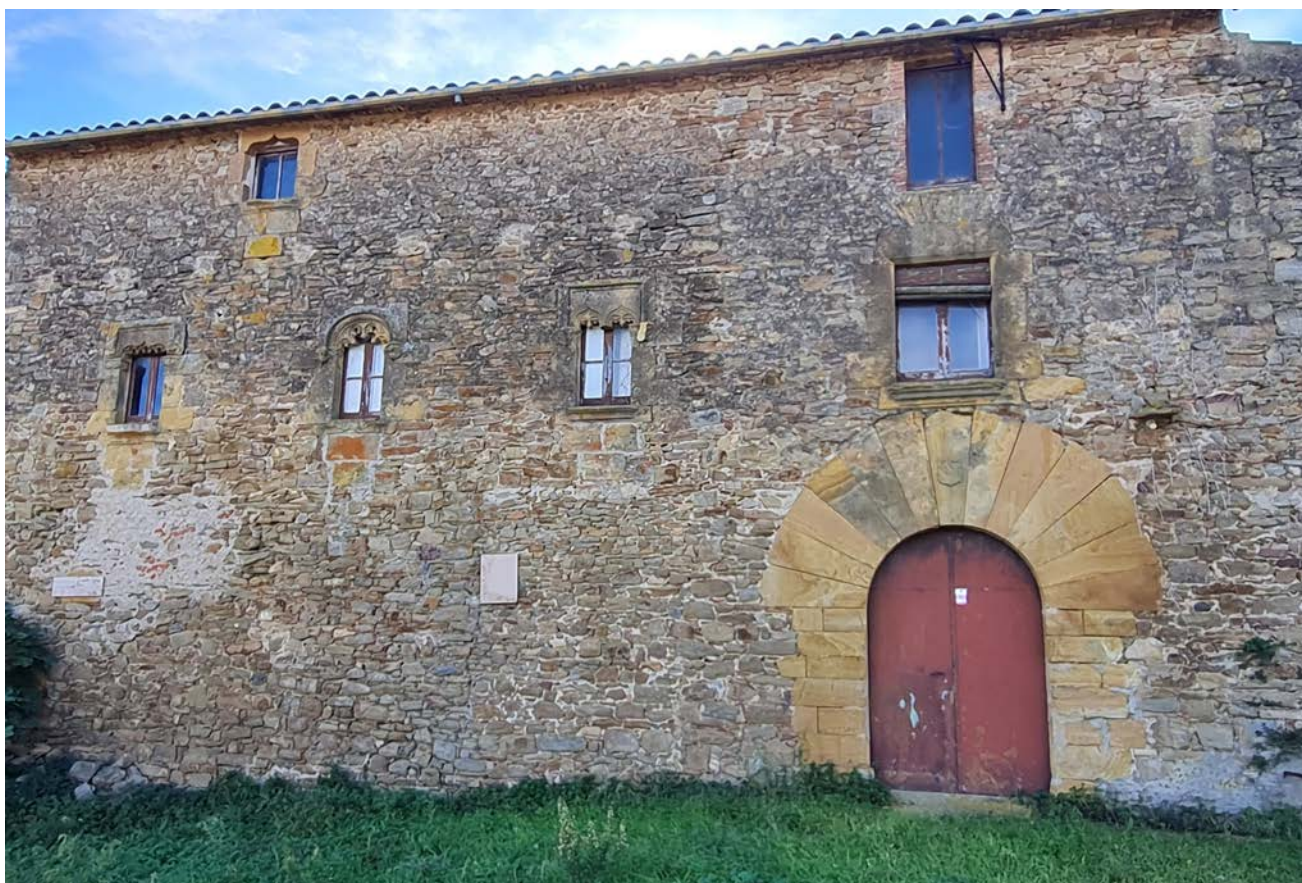
Figura 1. Vista parcial de la façana principal de l'edifici, orientada a nord.
