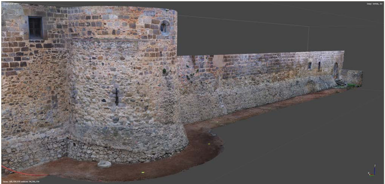
Figura 2. Imatge fotogramètrica en 3D de la part de muralla i del talús, i de la bestorre existent en el tram estudiat (foto Pau Castillo).
