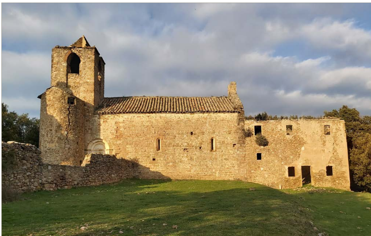
Figura 1. Vista de la façana sud de l'església de Santa Maria de l'Estela.
