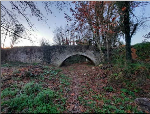
Figura 1. Costat nord del pont de Torrent.
