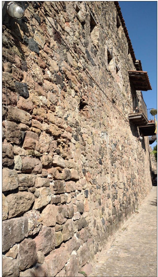
Figura 2. Vista general de la façana oest de la casa des del sud.
