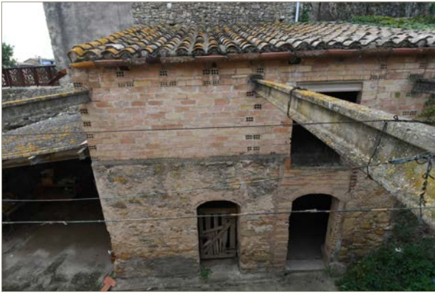
Figura 1. Cobert abans d'enderrocar situat sobre el fossat.
