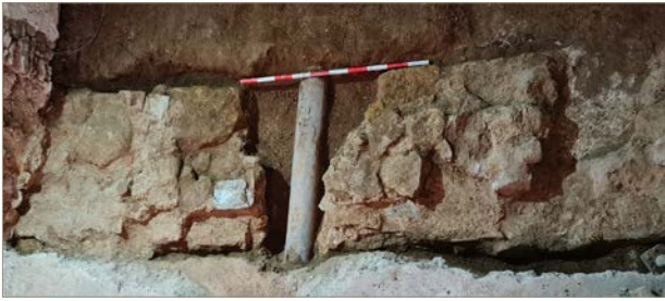
Figura 1. Localització i disposició del tram de muralla.
