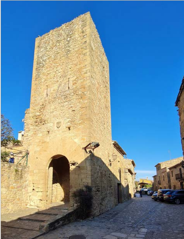
Figura 1. Carrer i torre.
