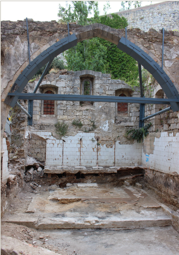
Figura 2. Vista general des de l'oest.
