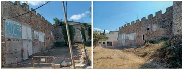
Figura 2. Imatges del tram de muralla un cop finalitzat l'enderroc.
