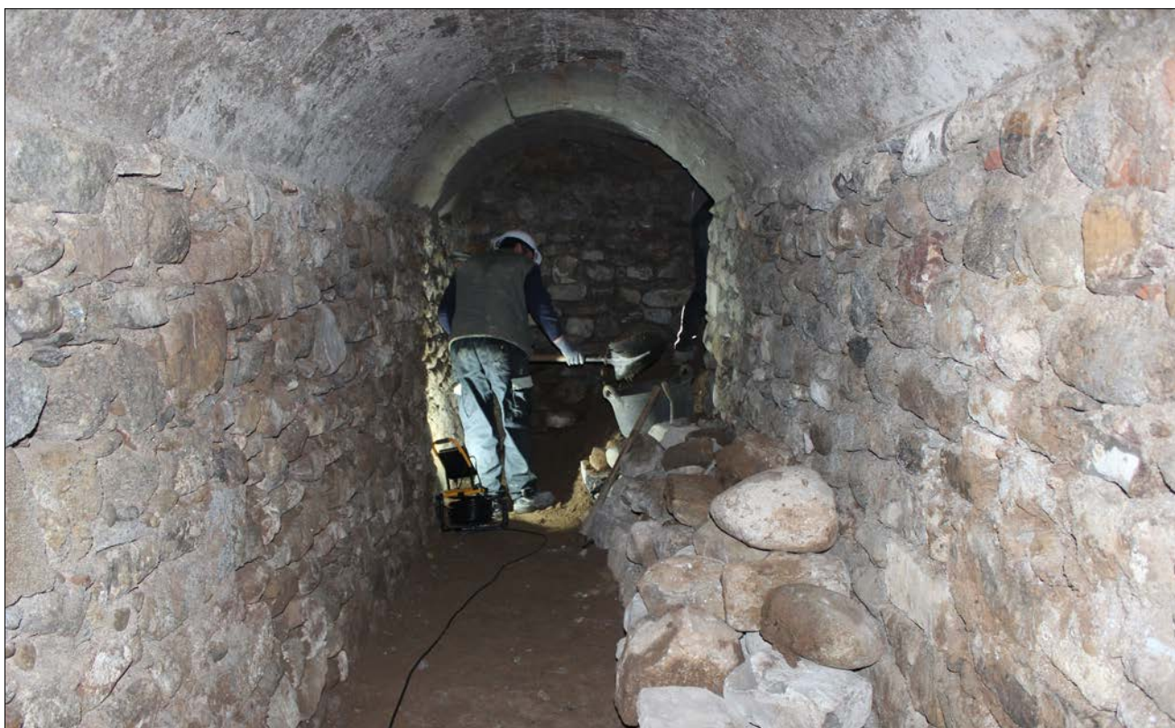
Figura 1. Treballs d'excavació a l'interior del refugi.
