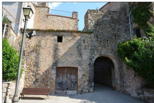
Figura 1. Vista frontal de la façana sud de l'edifici des del carrer dels Horts, amb el Portal Mitger al costat est.
