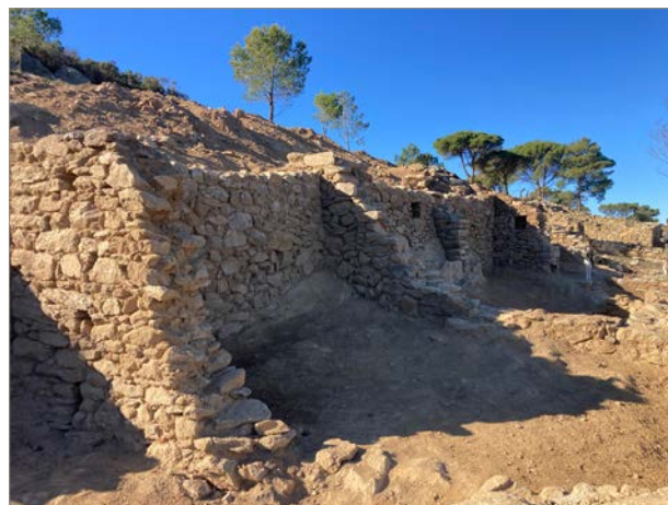
Figura 2. Vista general d'un dels sectors intervinguts, després de la darrera intervenció.
