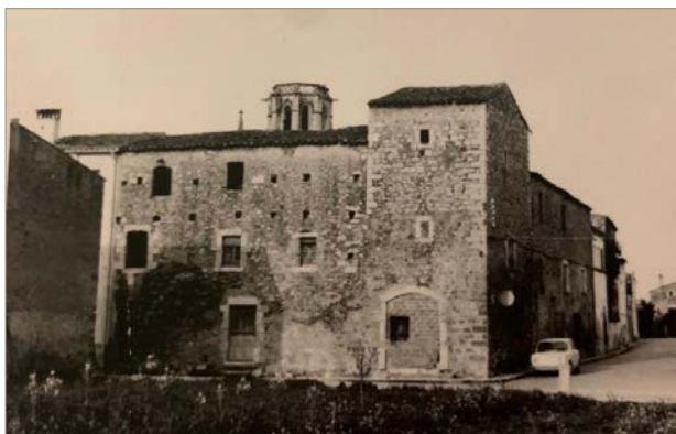
Figura 2. Fotografia de mitjan del segle XX on es pot apreciar a l'esquerra de la imatge, una part de la façana del castell arrebossada de color blanc. Aquest canvi de parament assenyala una altra propietat. Aquesta imatge en comparativa amb la façana actual, permet conèixer les darreres transformacions de l'edifici (fase dels segles XVIII-XX). S'aprecien els forats de bastida per l'aixecament de la segona planta en el cos de ponent. Font: gentilesa de l'actual propietat.
