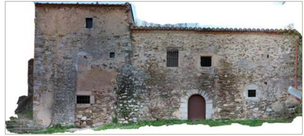
Figura 2. Ortofotografia parcial de la façana septentrional de l'antiga rectoria. Es pot apreciar amb claredat la torre original (a l'esquerra) i el cos afegit posteriorment (a la dreta).
