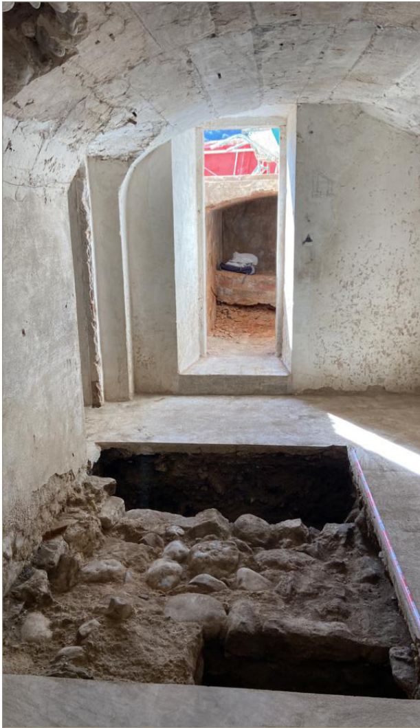
Figura 1. Soterrani on s'ha realitzat la intervenció, una vegada localitzades i excavades les estructures. Estructures vistes en direcció al carrer de la Font i el riu (sud-est).
