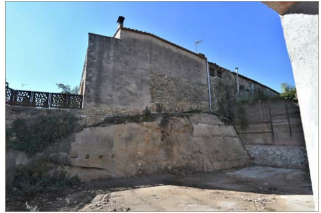
Figura 2. Vista general un cop eliminat l'edifici.
