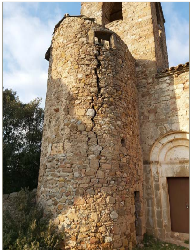
Figura 2. Escala annexa, en forma de torre semicircular, amb l'esquerda longitudinal.
