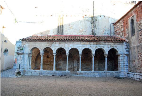
Figura 12. Galeria nord del claustre del monestir restaurada l'any 1931 per l'arquitecte cap del Servei del Patrimoni de la Diputació de Barcelona Jeroni Martorell. 17/NOV/2021 (E. Píriz).
