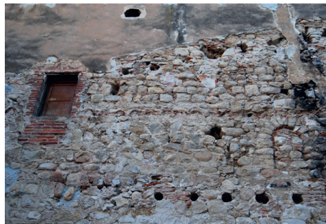
Figura 14. Façana interior de l'ala est del claustre, on es pot veure la ubicació de la coberta de teula ceràmica fossilitzada al mur per sobre de la finestra romànica. 17/NOV/2021 (E. Píriz).
